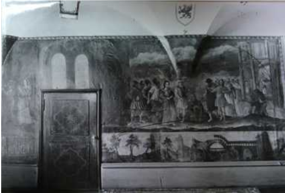
Fot. 7. Fragment zdjęcia z 1961 r. Widoczny namalowany herb z gryfem pomorskim na sklepieniu. Fot. z „Dokumentacji prac konserwatorskich” PPKZ 1961 r.
