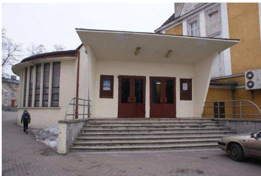
Fot.1 Elewacja frontowa
