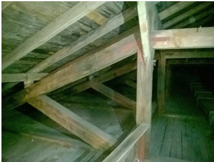
Fot. 5 Więźba dachowa
