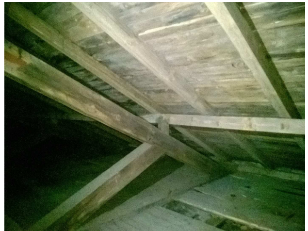
Fot.16. Więźba dachowa
