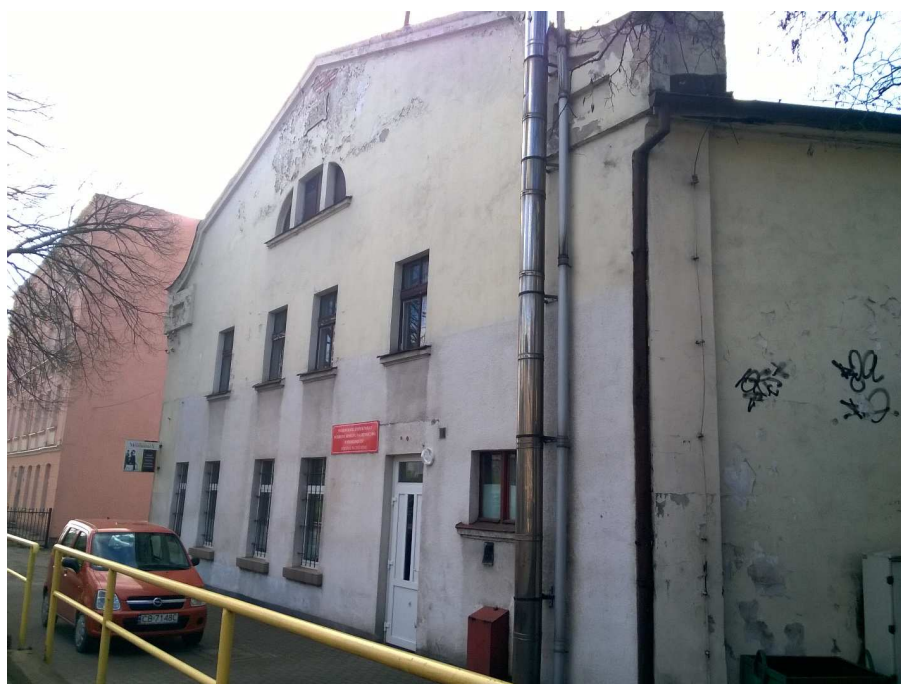
Fot. 3 Elewacja tylna
