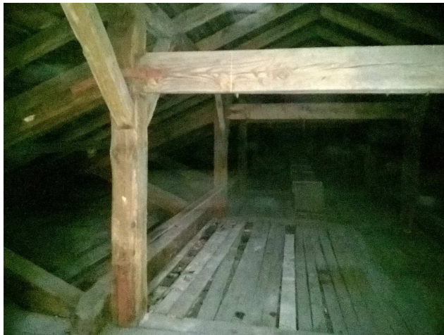
Fot.15. Więźba dachowa
