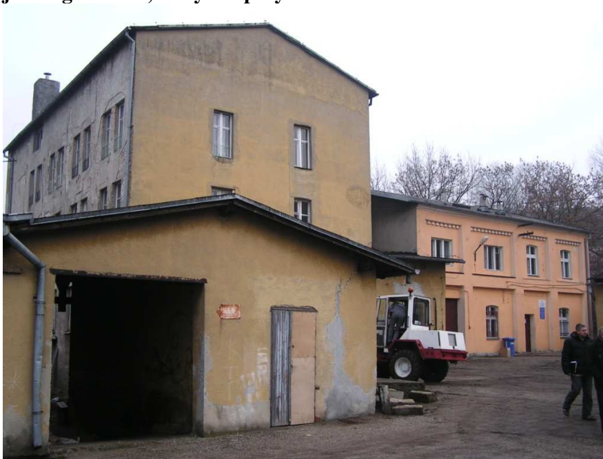
Chełmno, ul. Kamionka 3, Widok zabudowań od strony podwórza; na pierwszym planie zabudowania gospodarcze, w głębi na lewo budynek przeznaczony do adaptacji na funkcję mieszkalną po prawej na funkcje społeczne.
