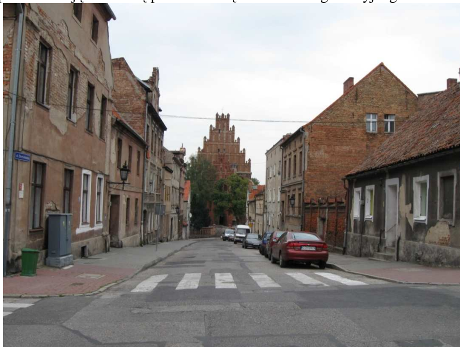
Chełmno, ul. Dominikańska Widok na ulicę i stan techniczny budynków.
