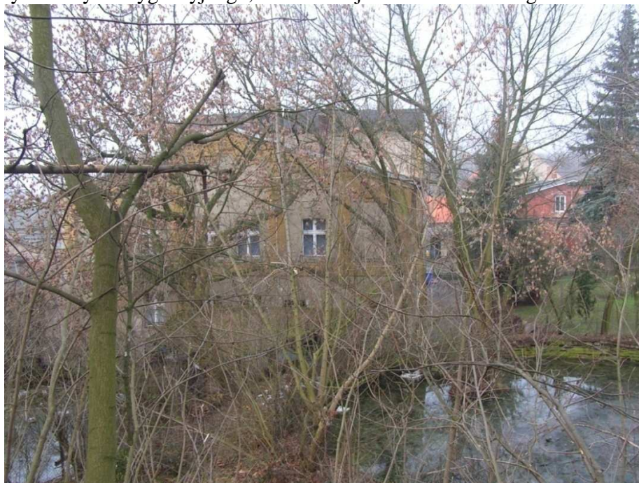
Chełmno, ul. Kamionka 3, Teren przy budynku, przeznaczony do zagospodarowania, istniejąca zieleń wymagająca uporządkowania.
