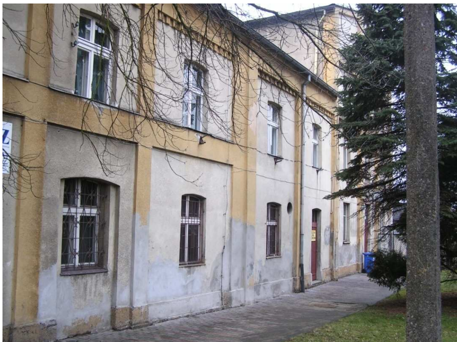
Chełmno, ul. Kamionka 3, Widok zabudowań od strony ul. Kamionka, widoczna konstrukcja szkieletu żelbetonowego.
