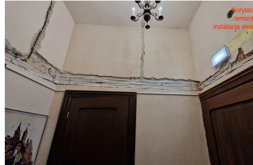
MODERNIZACJA INSTALACJI ELEKTRYCZNEJ W CZĘŚCI GOTYCKIEJ PARTERU CHEŁMIŃSKIEGO RATUSZA
