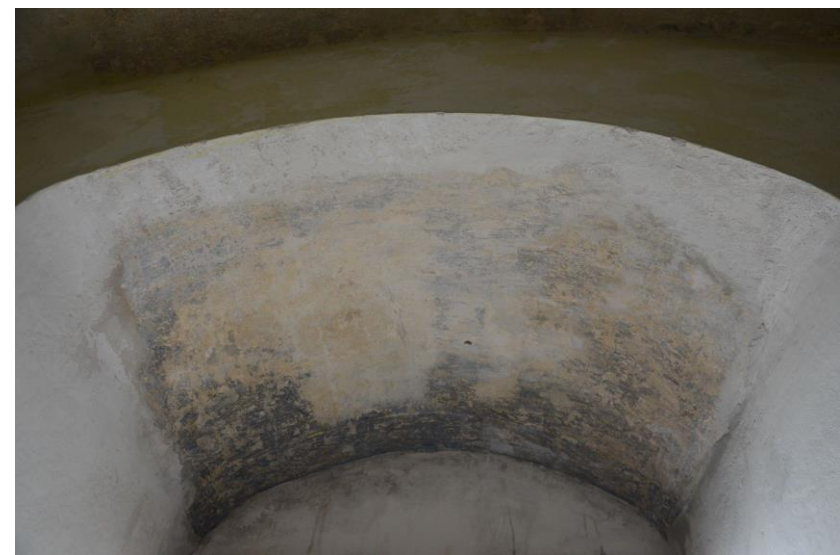
KONSERWACJA I RESTAURACJA SALI TAJNYCH POSIEDZEŃ – ETAP I
